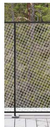
stalen balustrade met netvulling
