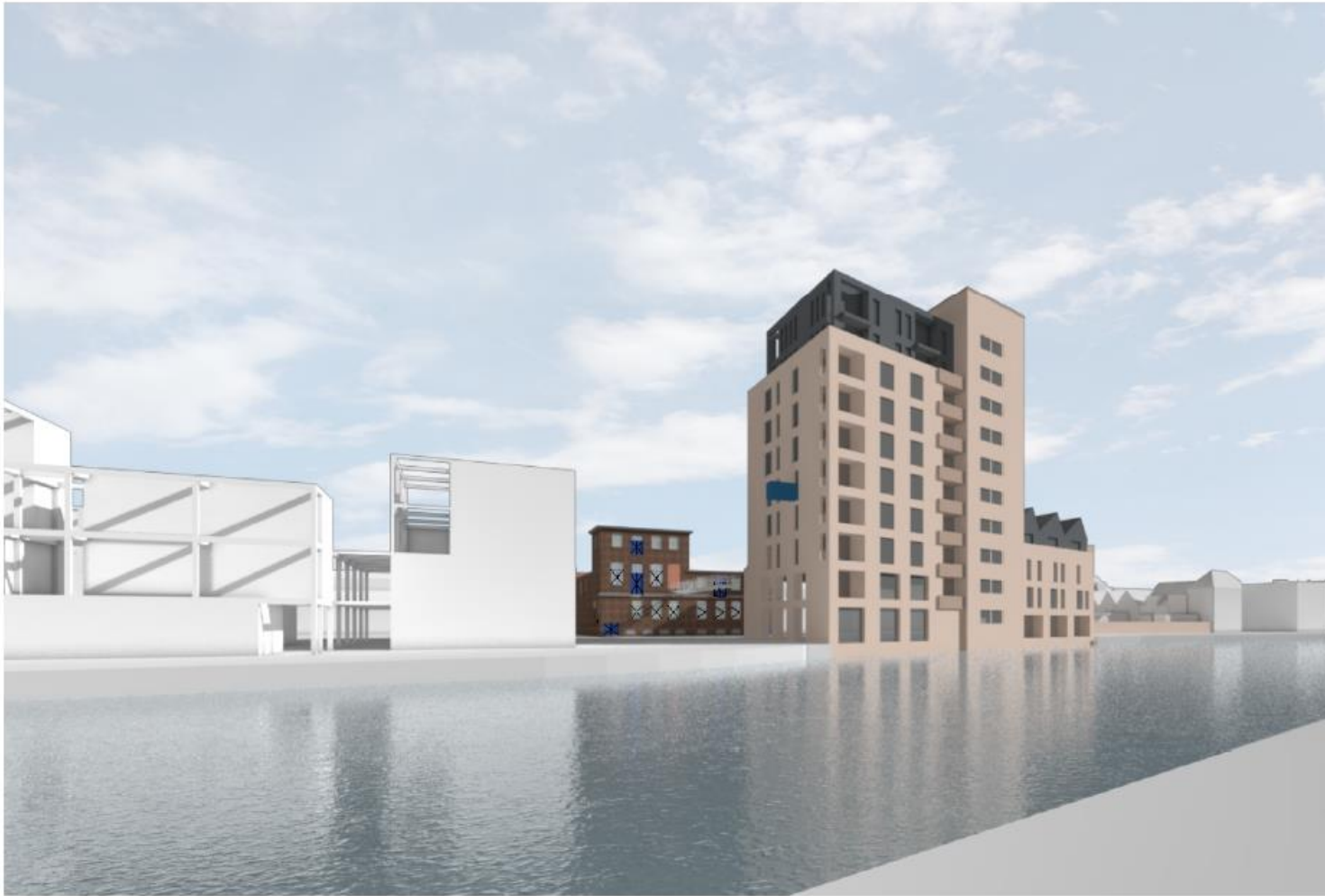
De zeepfabriek wordt in kleinere bouwdelen 'geknipt' door sprongen in de gevel en een optop-verdiepingen in een ander materiaal.
