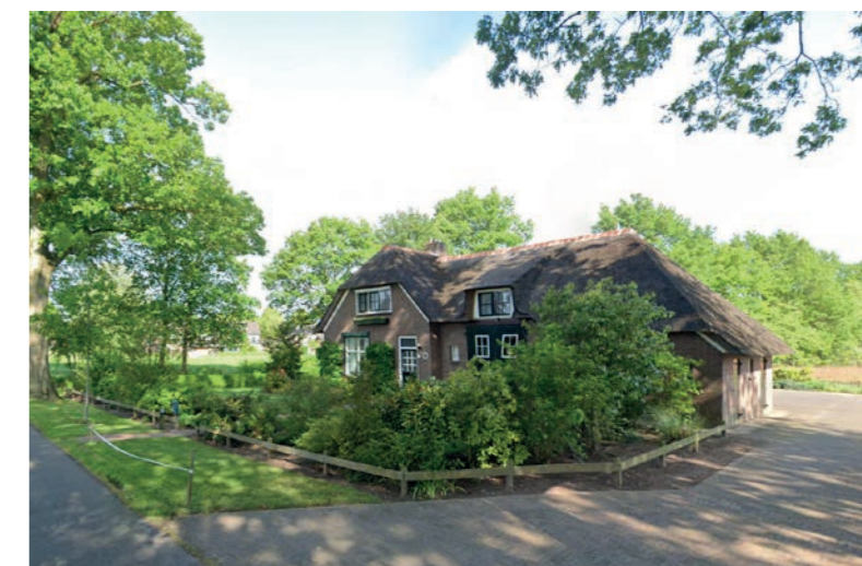
Lintbebouwing aan de Oerdijk
