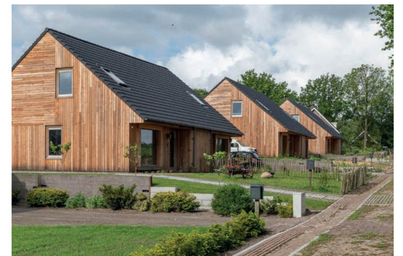
Open kopgevels en overdekte entree
