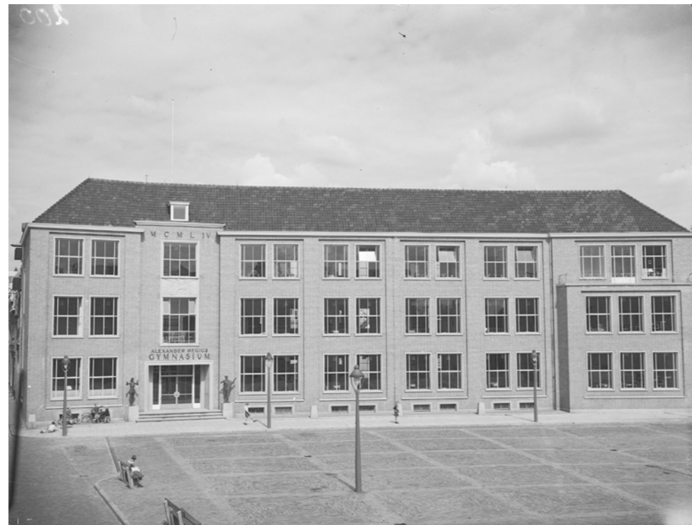
1956 GYMNASIUM EN VOORLIGGENDE STOEP GAAN SAMENSPEL AAN
