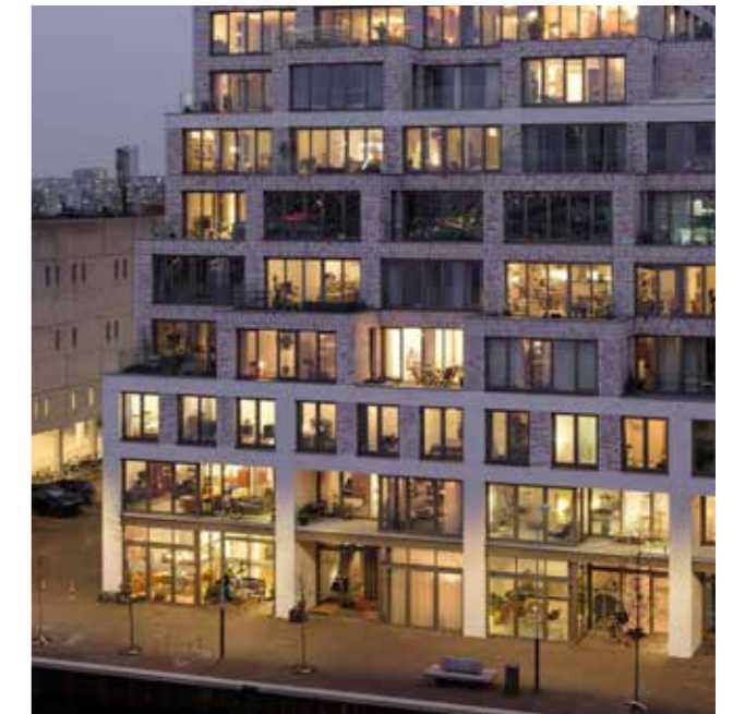
De Bocht, Cruquius - Amsterdam, 3 laagse stadswoningen aan de straat met daarboven appartementen (bron: Levs Architecten)
