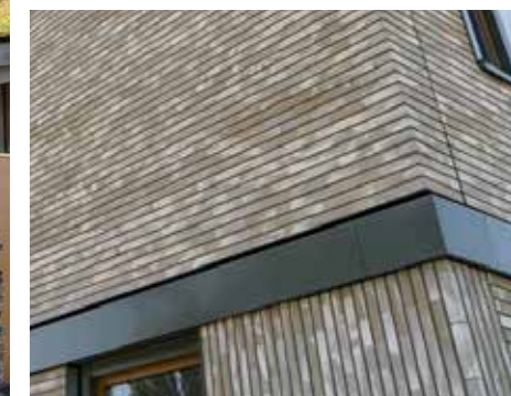
Afwijkend materiaal / metselverband begane grondverdieping
