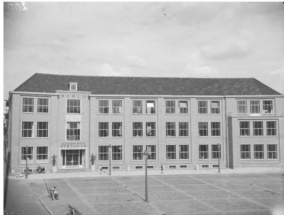
1956 GYMNASIUM EN VOORLIGGENDE STOEP GAAN SAMENSPEL AAN
