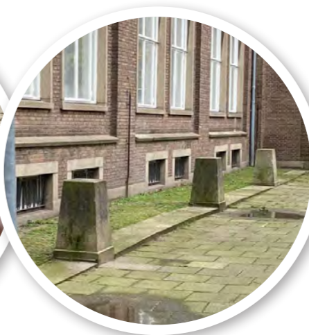
bestaande betonnen plint en zuilen en achterliggende bestrating behouden
