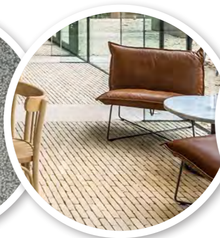
bestrating bordes gele gebakken klinker gelijk aan klinker in strook langs gevel
