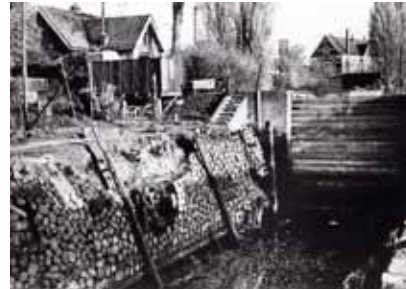
datering foto onbekend, de sluis met op de achtergrond de sluiswachterswoning
