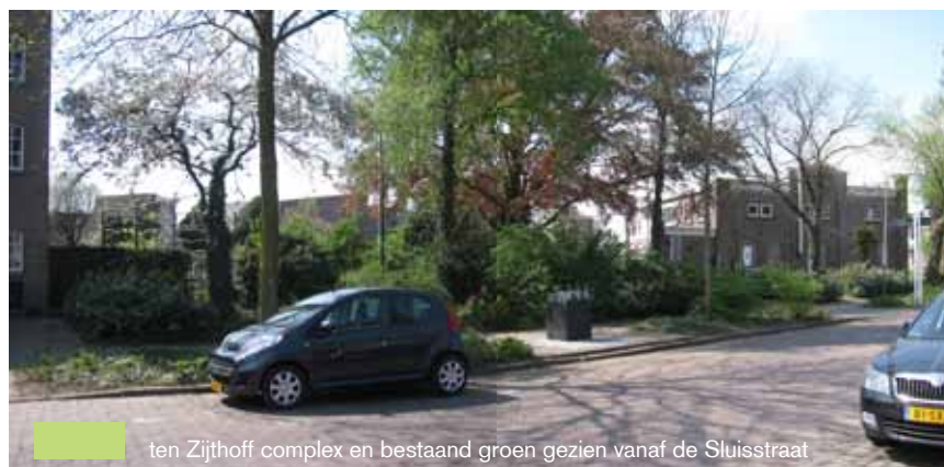
■ hart Sluiskwartier, vroeger hier vanuit de haven de toegang naar de sluis
