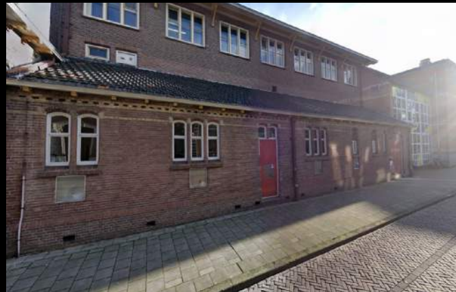
Kans meer openen van de gevel gymzaal
