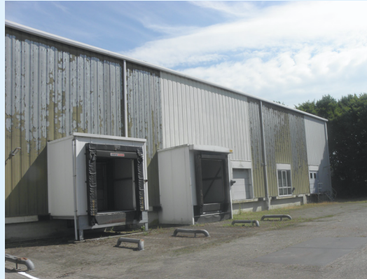
Loading docks van de voormalige Aupingfabriek
