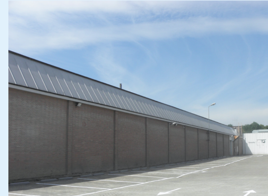
Hallen van de voormalige Aupingfabriek
