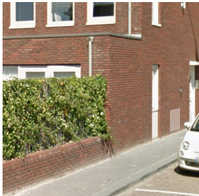
samenhang tuinmuur met gevel
