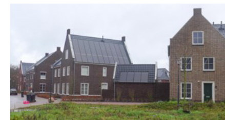
hoek met garage als huisje en tuinmuur
