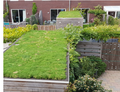
groen dak op berging extensief
