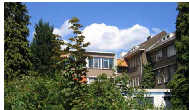
Huidige laagbouw tussen de beddenvleugels wordt gesloopt
