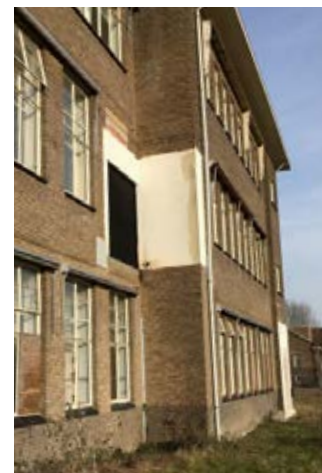
Bestaande beschadiging na sloop van verbindingsgang naar het na-oorlogse ziekenhuisgedeelte
