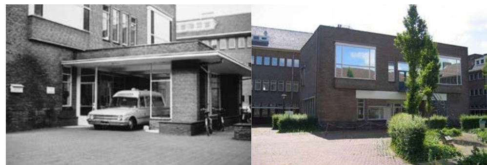
Te slopen voormalig opnamegebouw/operatiekamer op de binnenhof
