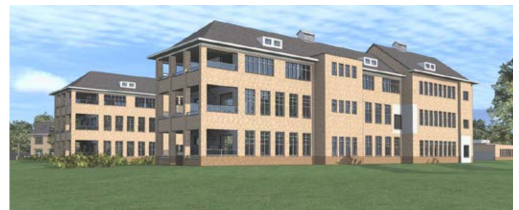
De oude loggia's worden hersteld. Balkons worden toegevoegd ter plaatse van de beschadiging.
