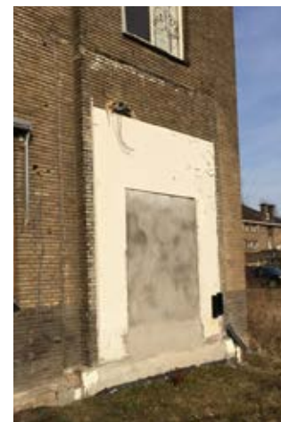
Bestaande beschadiging na sloop van verbindingsgang naar het na-oorlogse ziekenhuisgedeelte
