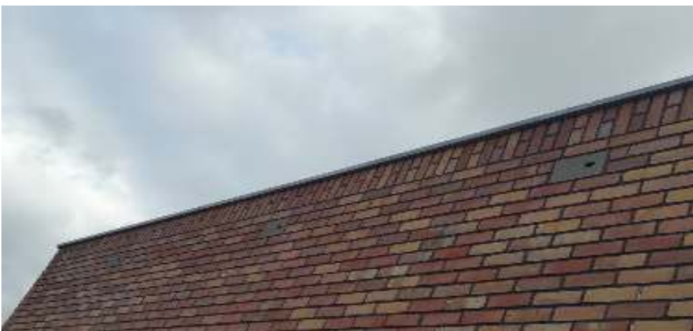
Figuur 42. Ingemetselde Gierzwaluwkasten ter compensatie voor de bouw van het nieuwe gemeentehuis in Deventer. Bron: Matthé Wind
