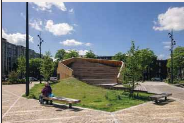
Speelobject en tribune met berging, transformator en fietsenstalling
