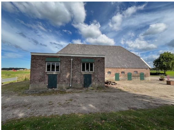
Figuur 4. Westgevel stal.
