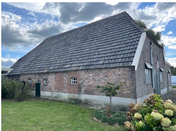
Figuur 6. Oostgevel stal.
