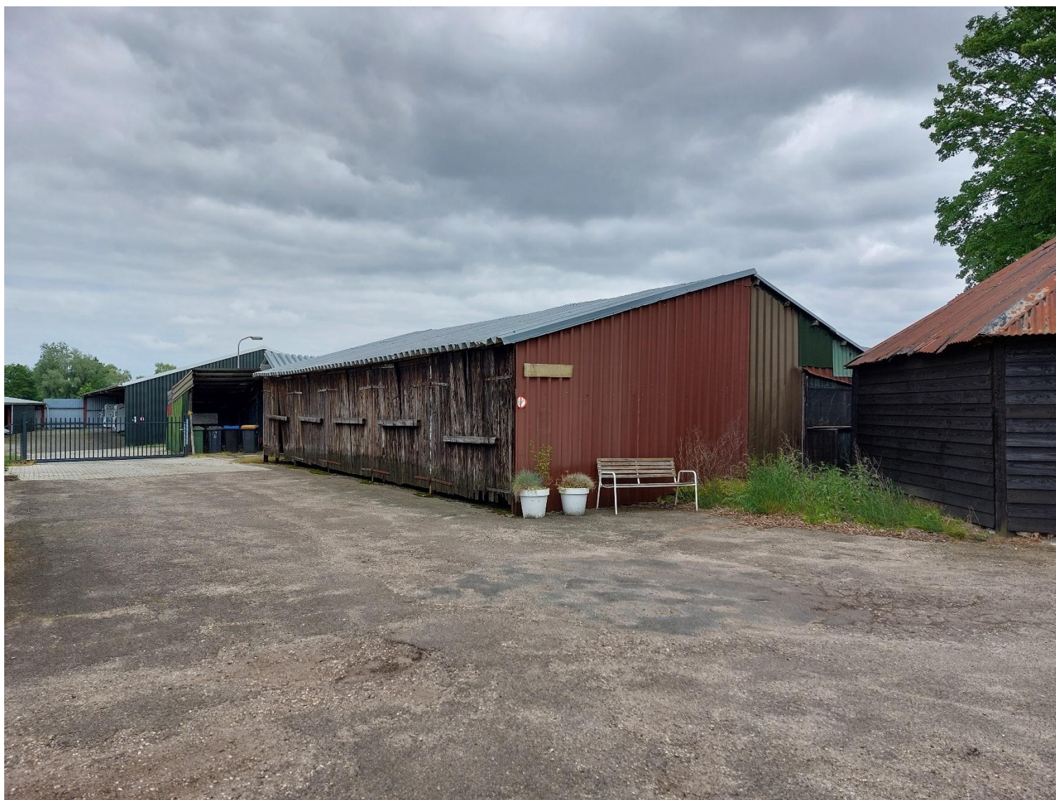
Afbeelding 7: Te verbouwen schuur, situatie op 25 mei 2023.
