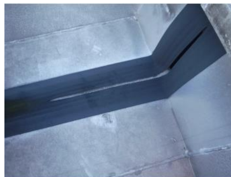
Foto 6 Scheur in expansiestuk.
