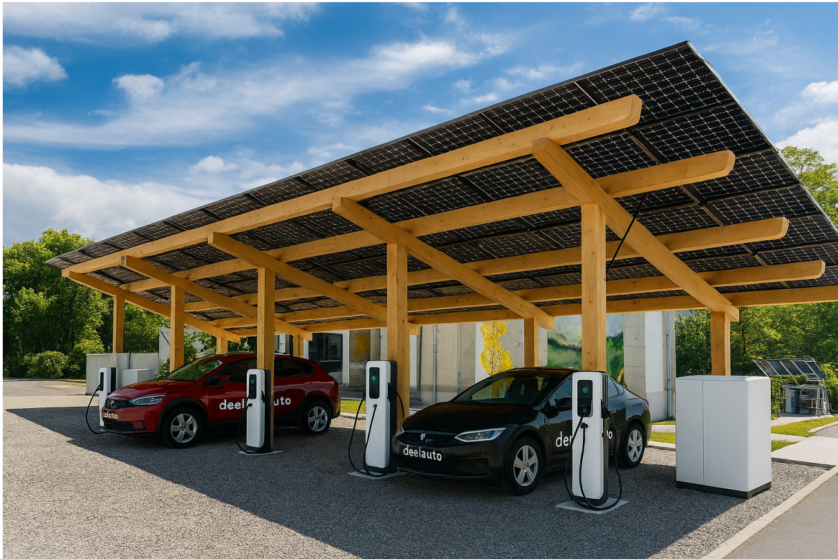
Figuur 1 Impressie van een solarcaport met laadvoorzieningen en een batterij voor opslag.
