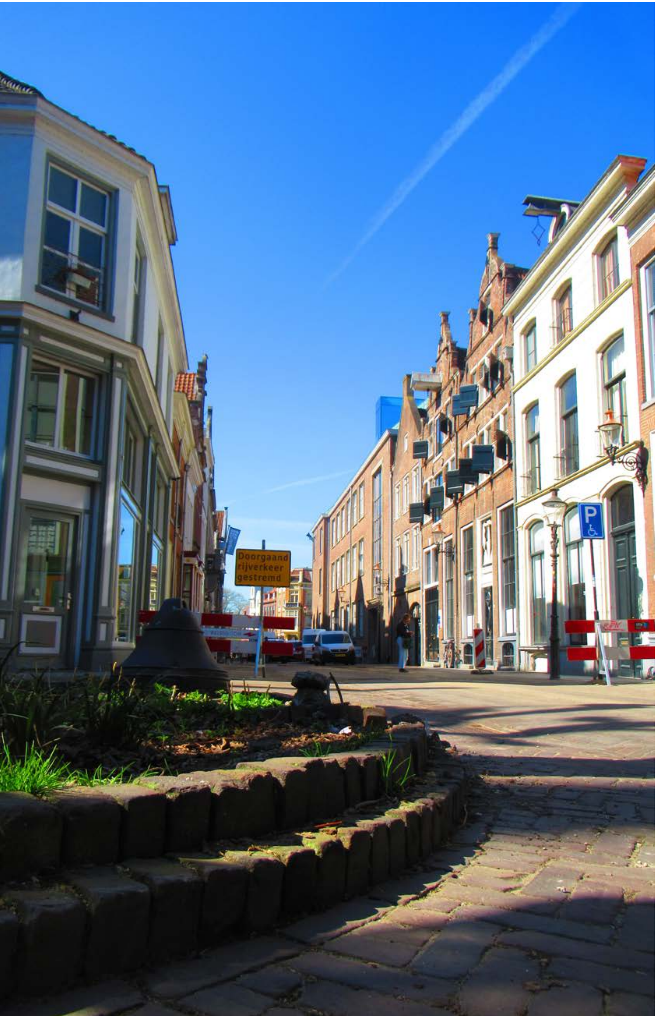
Hergebruikte klinkers als randafwerking
