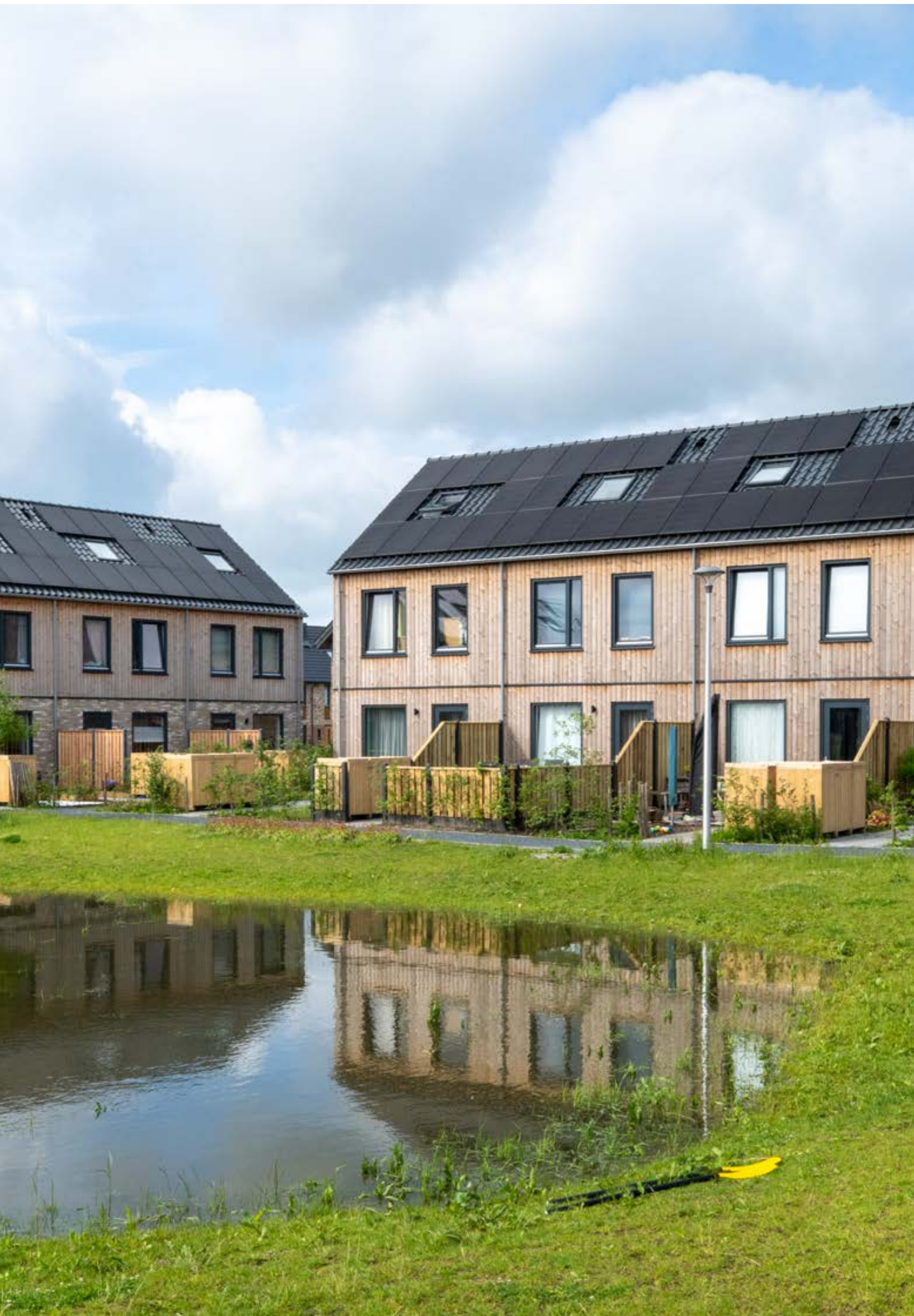
In Almelo staat de Slimme Huizenfabriek van Plegt-Vos. In deze fabriek zetten robots jaarlijks meer dan duizend kant-en-klare woningen en woningcomponenten in elkaar. Hout in plaats van beton is daarbij in toenemende mate het belangrijkste bouw materiaal. Project De Tippe - Plegt-Vos bouwbedrijf
