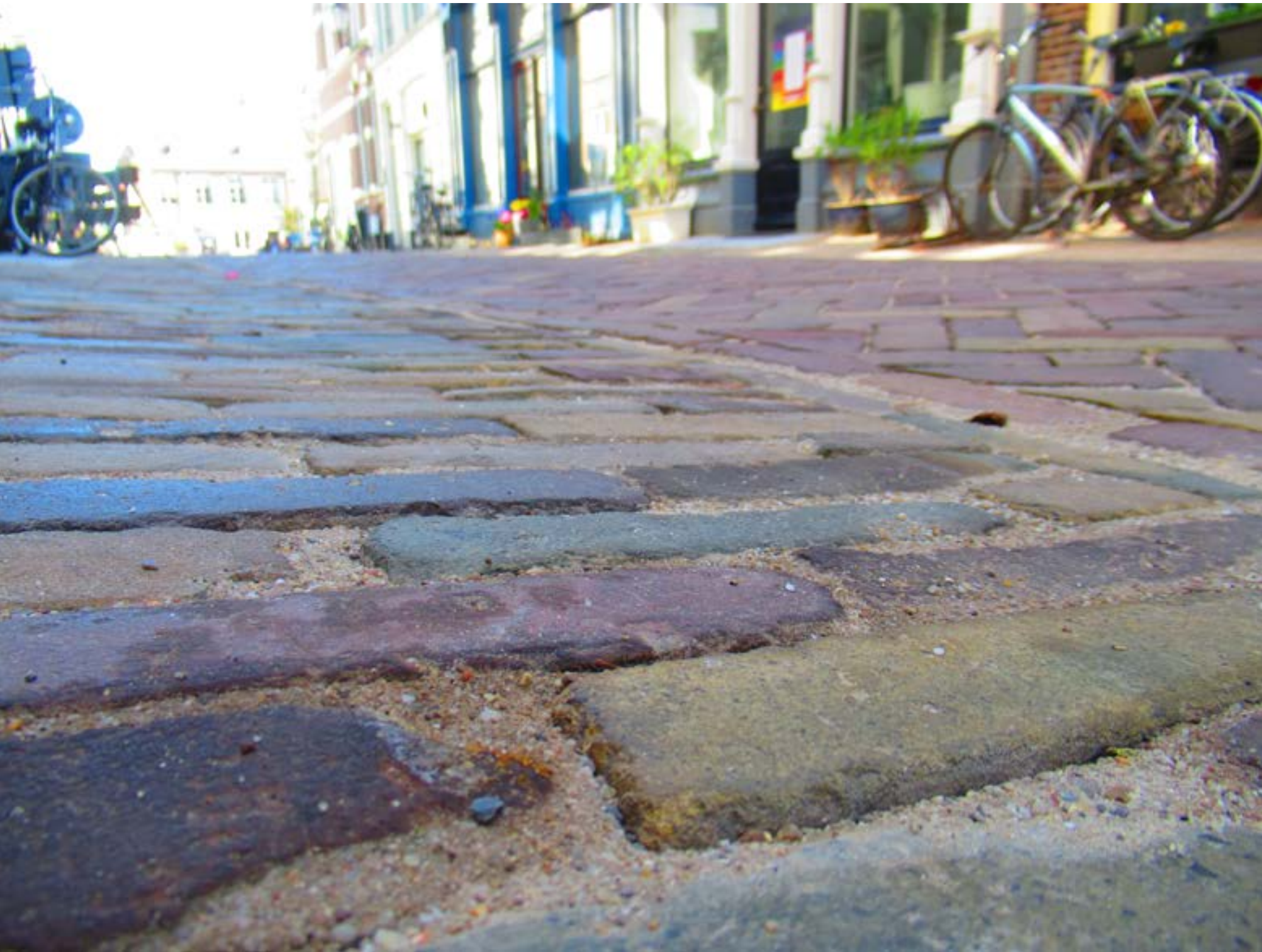
Hergebruik elementverharding binnenstad Deventer
