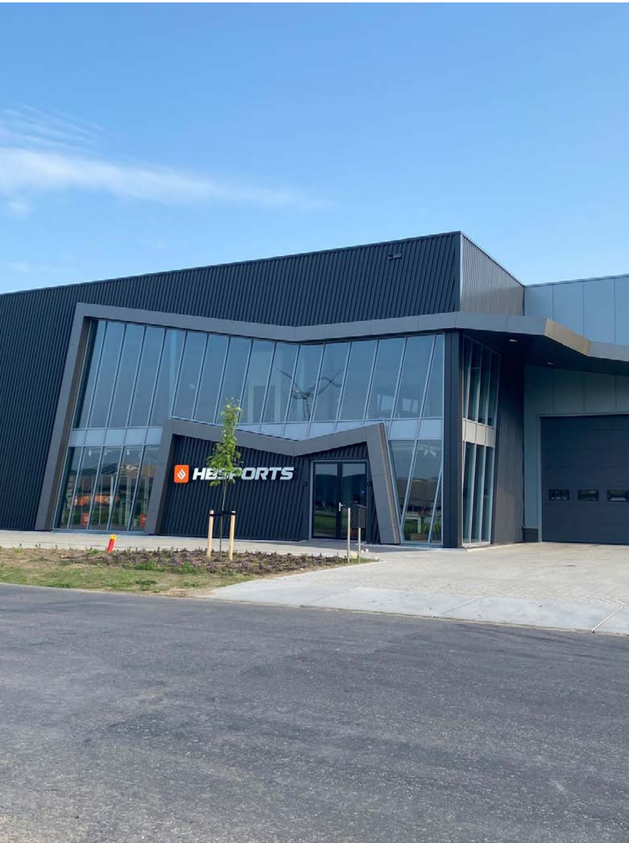
HB Sports op het Bedrijventerrein A1 Deventer. Duurzame en circulaire elementen. Losmaakbaarheid/demontabel en minder materiaalgebruik. Toepassing van gevelsandwichpanelen zijn 10% dunner met dezelfde isolatiewaarde.
