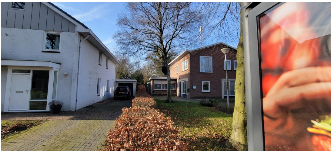
Kantoor brandweerkazerne zicht Afbeelding 2.6: Impressie van de onderzoekslocatie (bron: 6)
