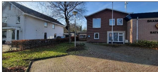
Foto 2: Brandweerkazerne gezien vanaf de Koekendijk 2 (d.d. 29 januari 2024)
