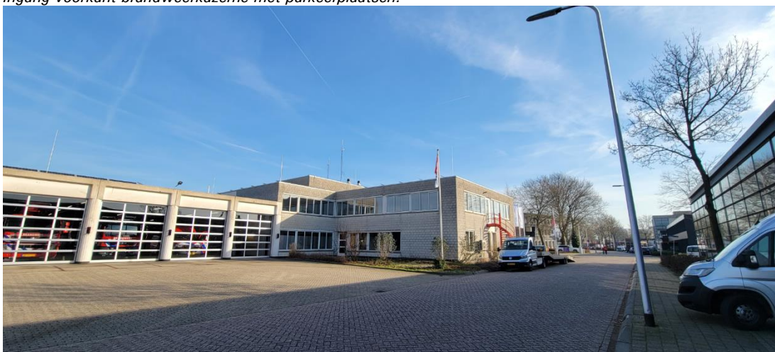
Brandweerkazerne, gezien vanuit de Schonenvaardersstraat
