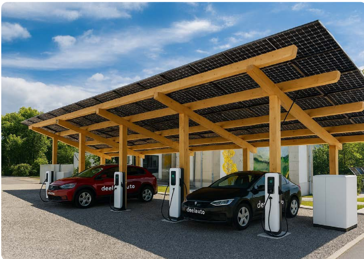
Figuur 1 | Impressie van een solarcaport met laadvoorzieningen en een batterij voor opslag
