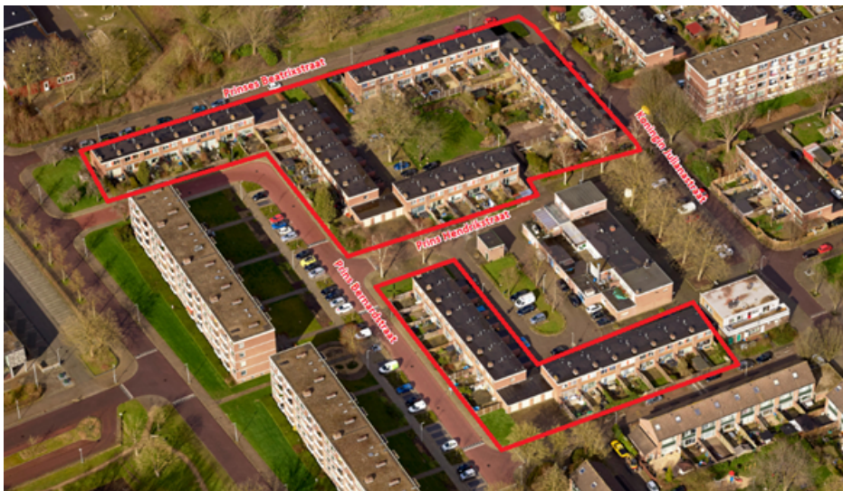
Afbeelding: bestaande situatie (2020) woningen gevelrenovatie
