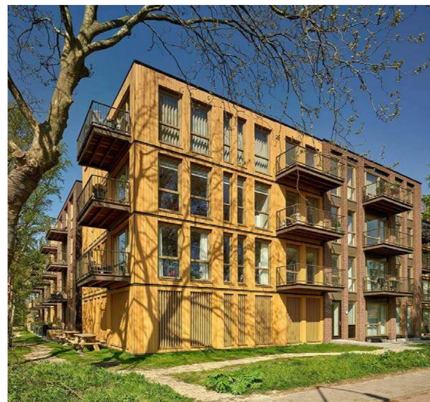
combinatie van hout en metselwerk
