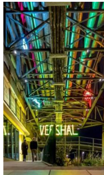
Verlichting gekoppeld aan brug
