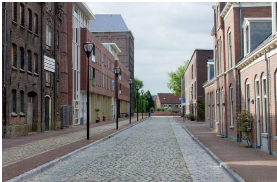
Raambuurt straat met natuursteen rijbaan en baksteen stoep
