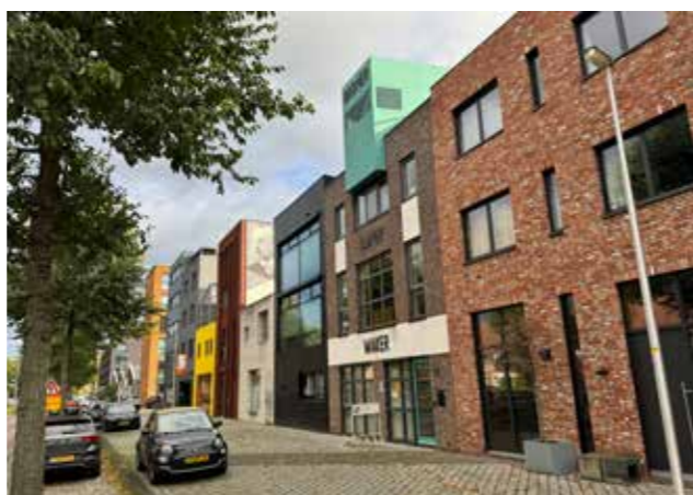
In het Deventer Havenkwartier biedt bebouwing van maximaal 5 bouwlagen (16 meter) ruimte aan een levendige mix van werken en grondgebonden en gestapeld wonen
