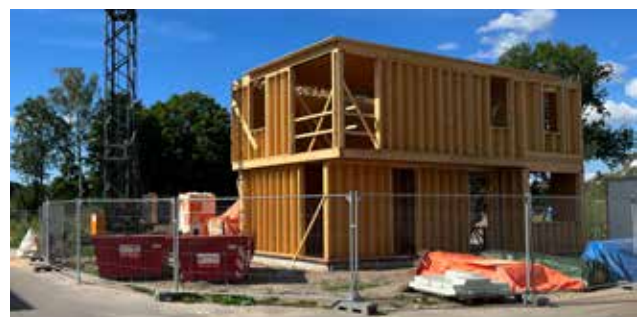
Houtbouw in de Tuinen van Zandweerd
