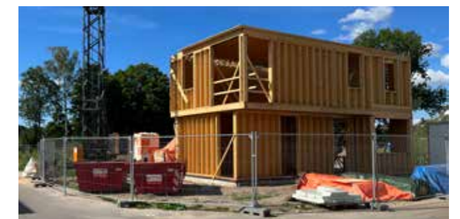
Houtbouw in de Tuinen van Zandweerd
