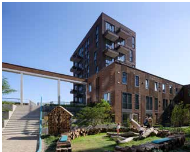
De Groene Kaap, Rotterdam: daklandschap met een aaneenschakeling van collectieve hoven en tuinen (bron: Bureau Massa)
