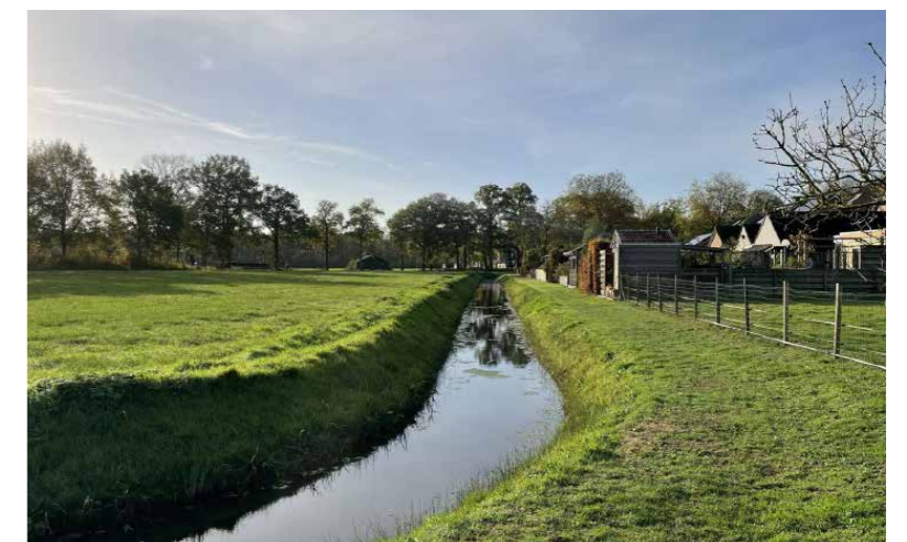
Watergangen zorgen voor de afvoer van oppervlaktewater
